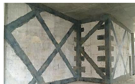
Усиление железобетонных стен углеволокном
