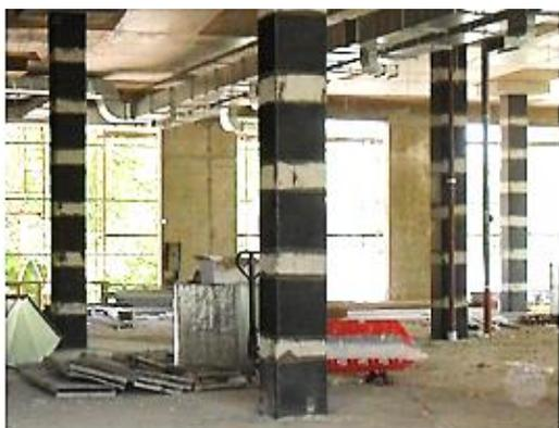
Рис. 1. Усиление конструкций композитными материалами
